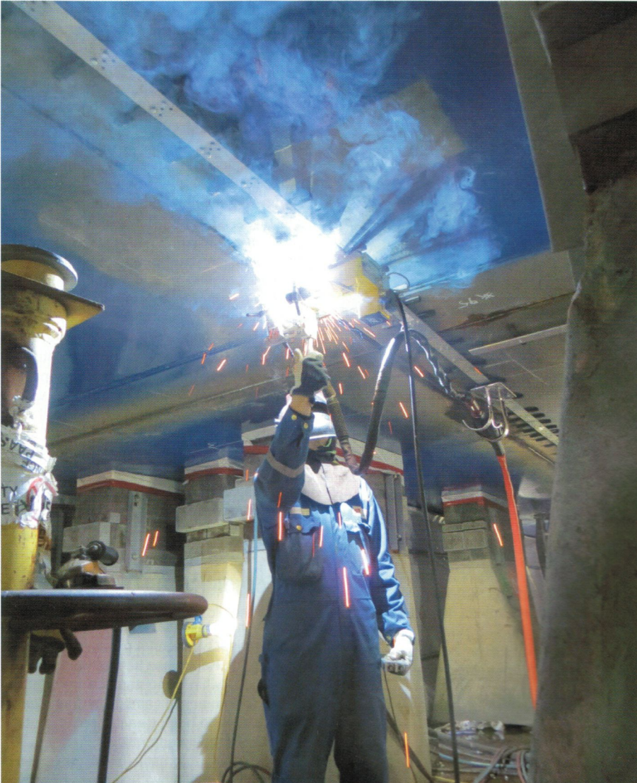
MAG-täytelankahitsausta käyttäen kuljetinta lakiasenossa.
